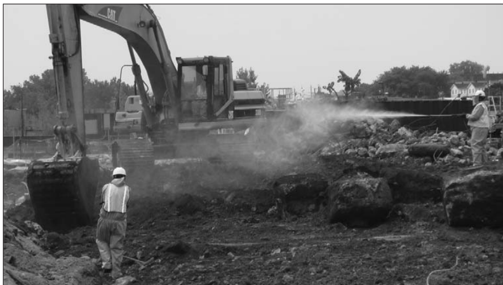
La excavación es el método elegido para la limpieza del sitio de Garfield Avenue, que PPG ha llevado a cabo desde julio como parte de la limpieza inicial.
